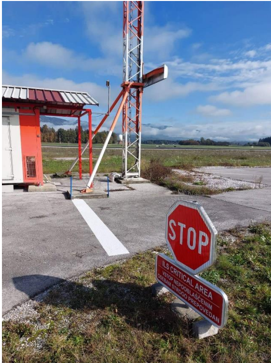
Slika 6.4.3; Način označitve ILS-GP kritičnega območja pred antenami (oznaka in znak).
